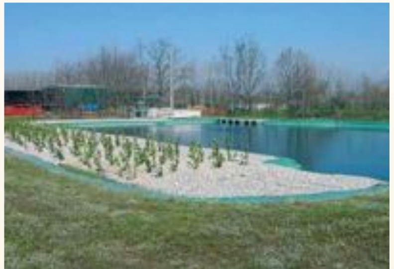
Vista general y agua en salida de una instalación de fitodepuración de flujo sub-superficial (700 H.E.)
