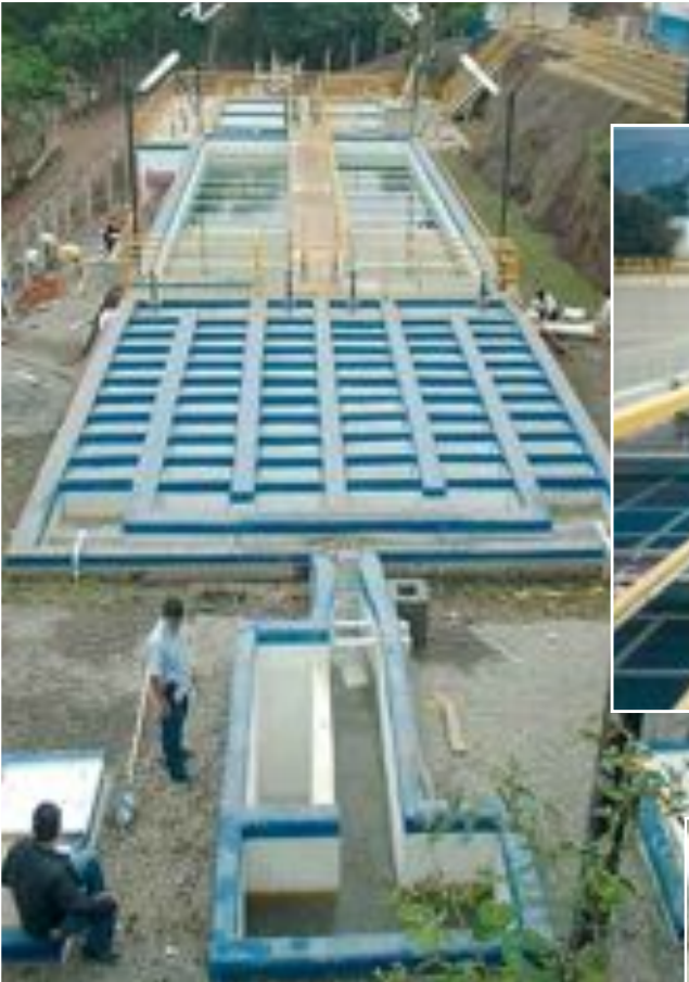
Estación tratamiento agua potable Q = 310 \text{ m}^3/\text{h} Año: 2003
