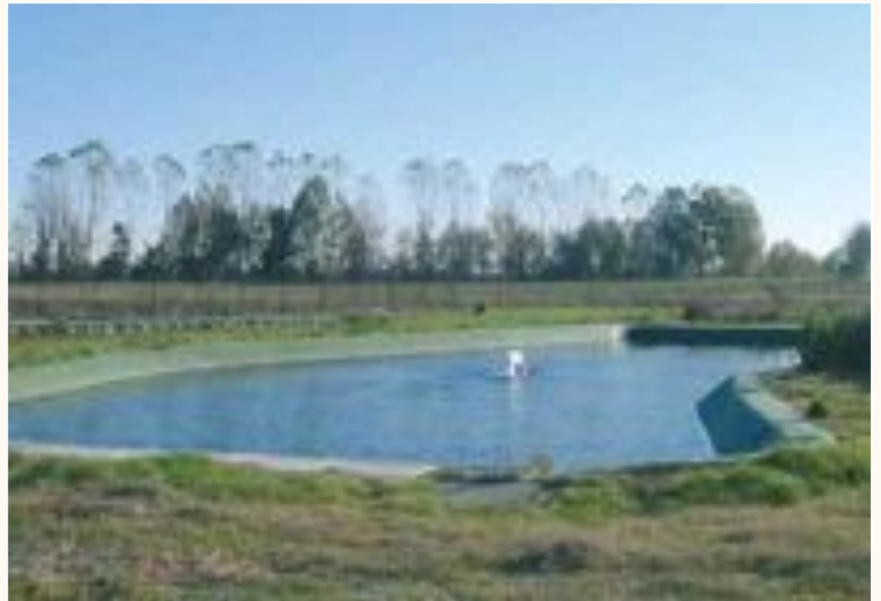
Instalación de 350 H.E.
