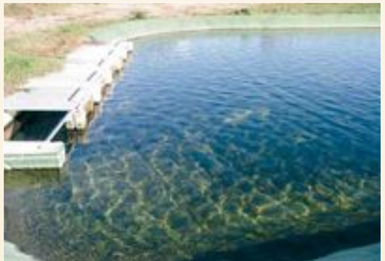
Vista general y agua en salida de una instalación de fitodepuración de flujo sub-superficial (700 H.E.)
