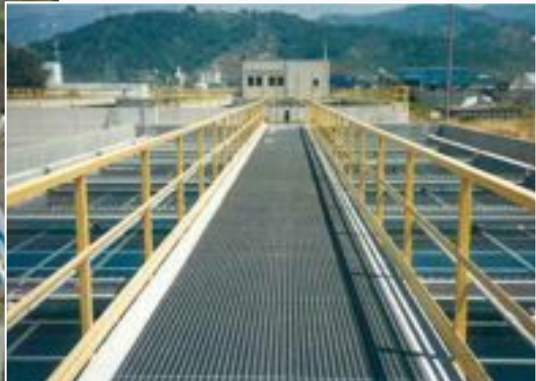
Sedimentador final centro urbano antes del biológico de lodos activos Q = 750 \text{ m}^3/\text{h} Año: 2000
