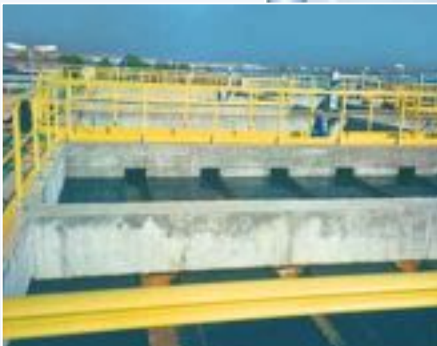
Sedimentación final Q = 4.788 m 3 /h Año: 2000
